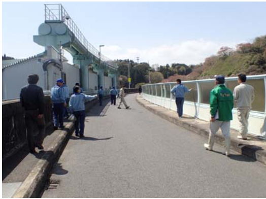
ダム天端道路点検状況
